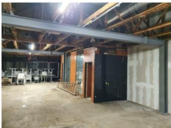
Zustand Halle innen
