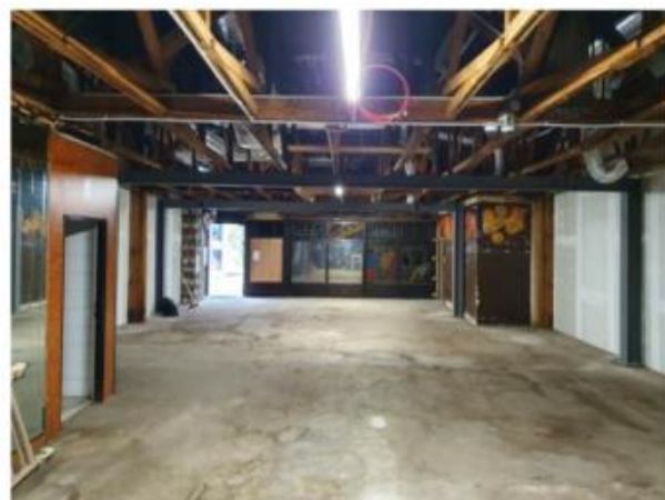
Zustand Halle innen
