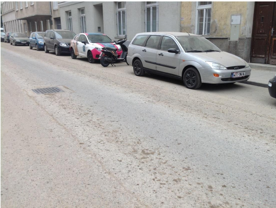
Abbildung 3: Verschmutzung eines angrenzenden Straßenzuges
