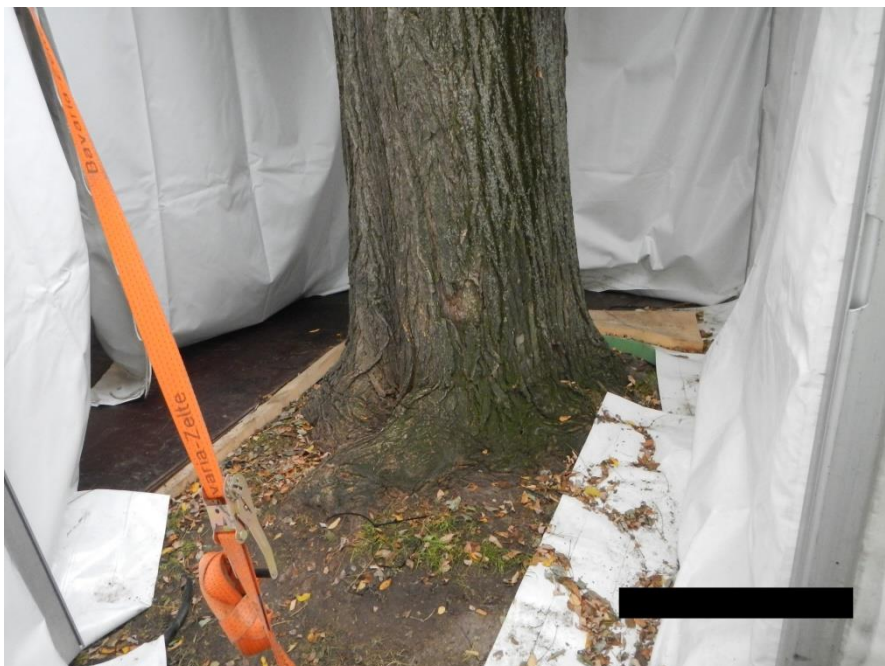
Abbildung 12: Gefährdung des Wurzelbereiches durch Aufbauten
