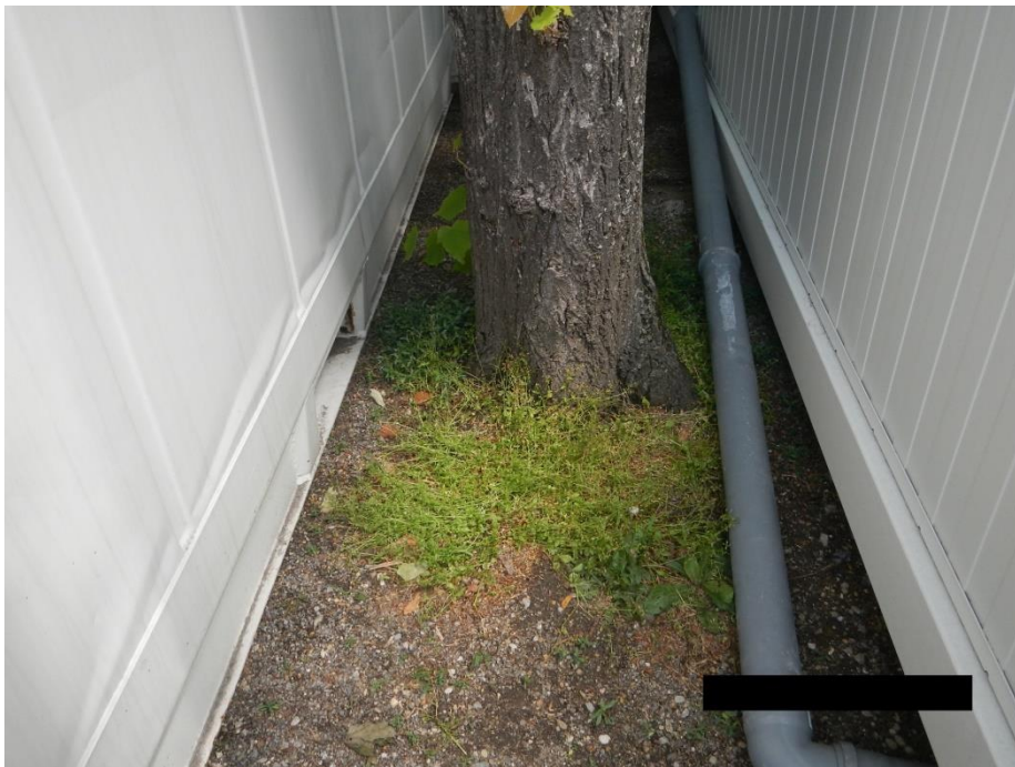
Abbildung 16: Aufstellung von Containerunterkünften im Schutzbereich
