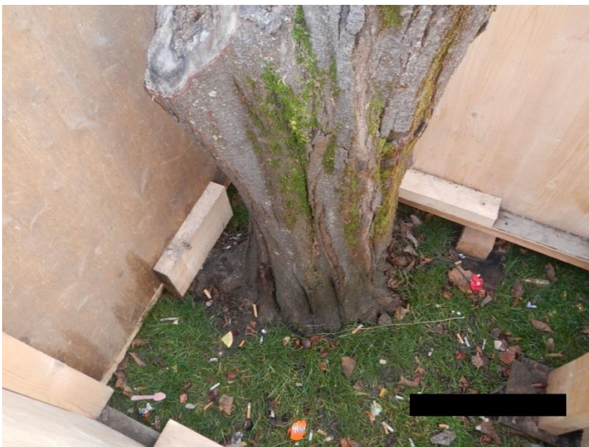
Abbildung 9: Nicht normgemäßer Stammschutz inkl. Gefährdung des Wurzelbereiches
