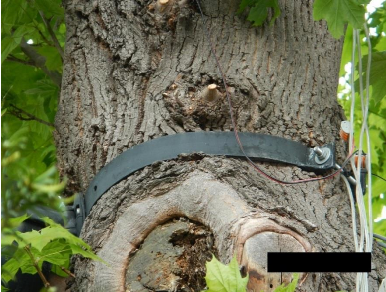
Abbildung 14: Nicht normgemäß ausgeführte Befestigungen
