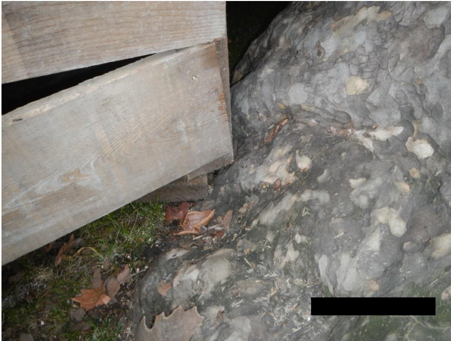
Abbildung 13: Gefährdung des Wurzelbereiches durch direkte Auflagerung von Aufbauten
