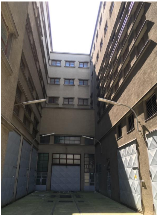
Abbildung 13: Umspannwerk Favoriten - Außenansicht 2 Innenhof
