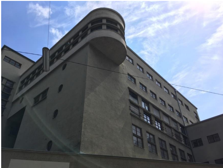
Abbildung 14: Umspannwerk Favoriten - Außenansicht 3
