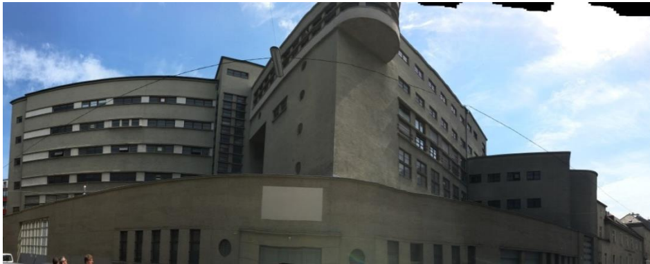
Abbildung 12: Umspannwerk Favoriten - Außenansicht 1
