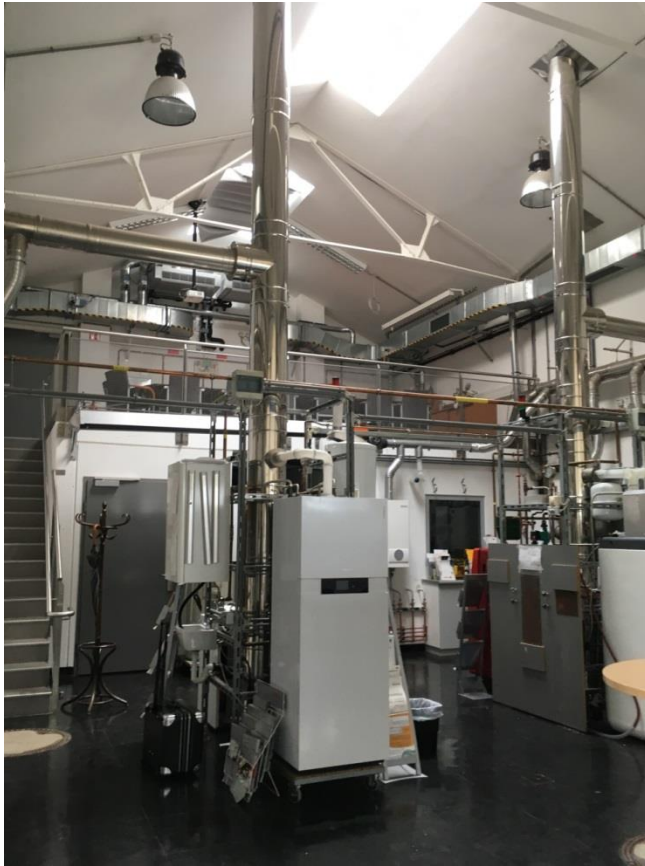
Abbildung 6: Technisches Kompetenzzentrum - Innenansicht 2
