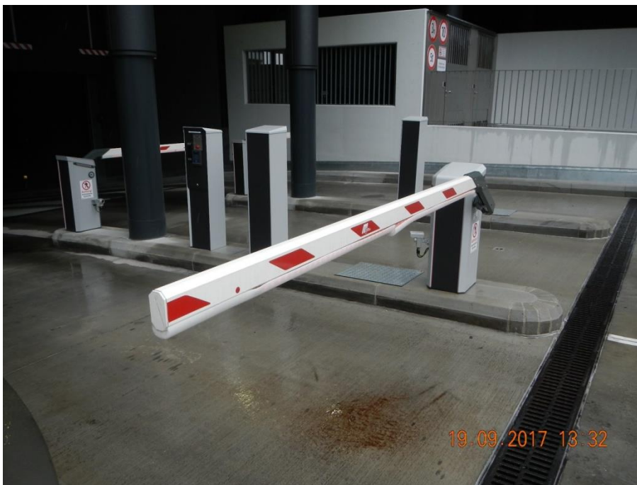
Abbildung 2: Einfahrt mit Schrankenanlage und Fahrzeugerfassungssystem im Smart Campus
