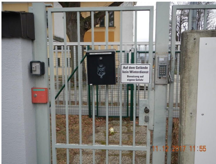
Abbildung 7: Eingangstür im Umspannwerk Ebenfurth
