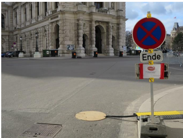
Abbildung 9: Provisorische Schachtabdeckung
