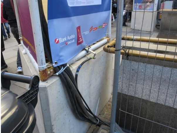
Abbildung 13: Schraubklemme mit Potenzialausgleichsleiter
