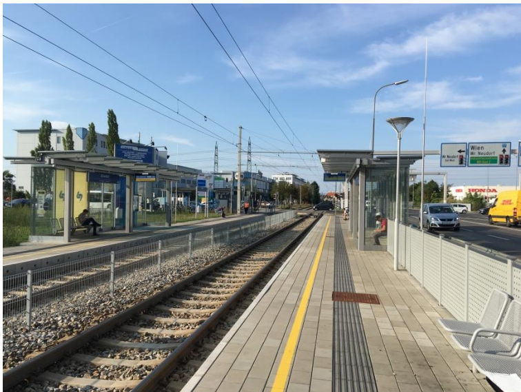
Abbildung 4: Modernisierte Haltestelle Griesfeld, aufgenommen am 26. August 2019
