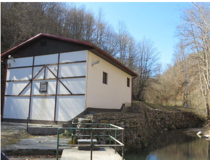
Abbildung 16: Kraftwerk Sućeska RS-2 - Außenansicht
