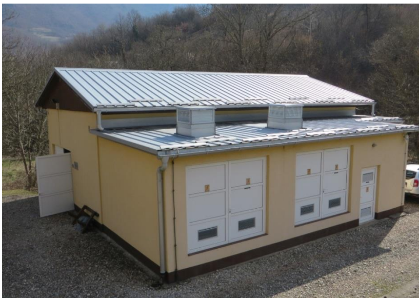
Abbildung 14: Kraftwerk Sućeska RS-1 - Außenansicht
