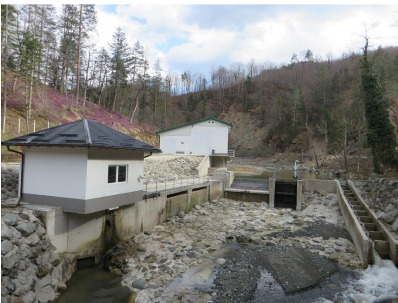
Abbildung 6: Kraftwerk Rujevica Ušće - Außenansicht
